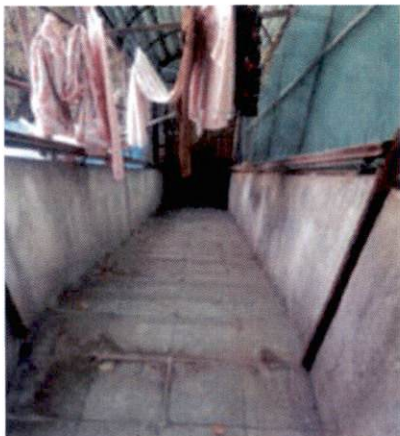
1、疏散通道内设置障碍物、通道门锁闭
