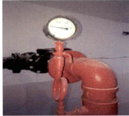
2、压力表无最高压力限值标识
