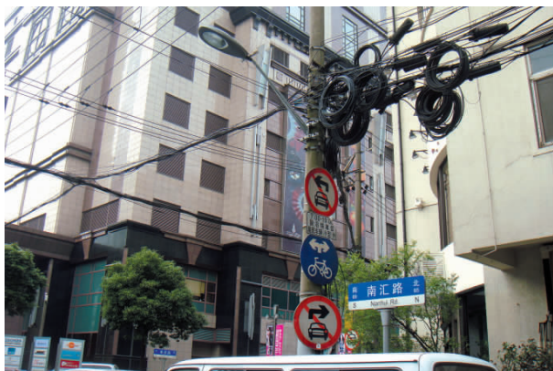
整理前的南汇路(奉贤路口)架空线
