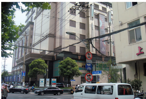
整理后的南汇路(奉贤路口)架空线
