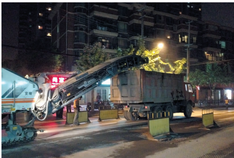
武定路重点养护夜间铣刨加罩施工
